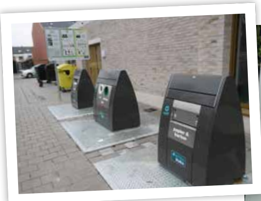
Ondergrondse afvalstraat De Boot-Sporthal
