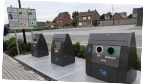
Ondergrondse afvalstraat Mazenzele
