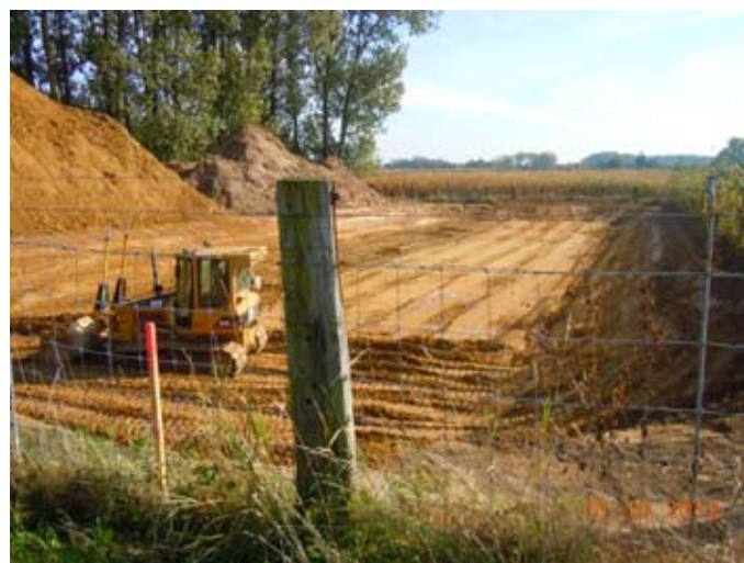
Foto boven: Realisatie bufferbekken Doortstraat
