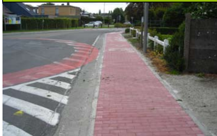
Heraanleg rondpunt Karenveldstraat / Droeshoutstraat en Nanovestraat
