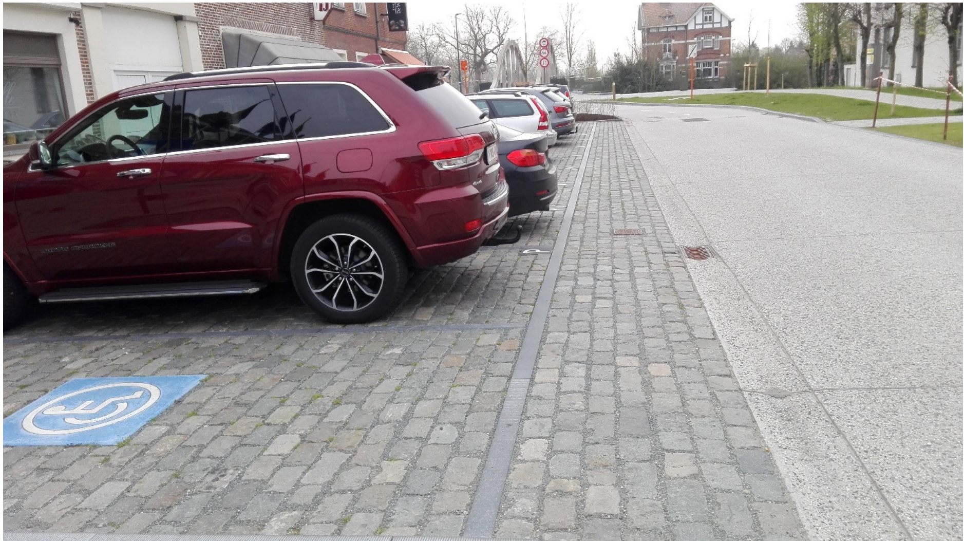
Combinatie parkeervak in kassei en rijweg in uitgewassen beton
