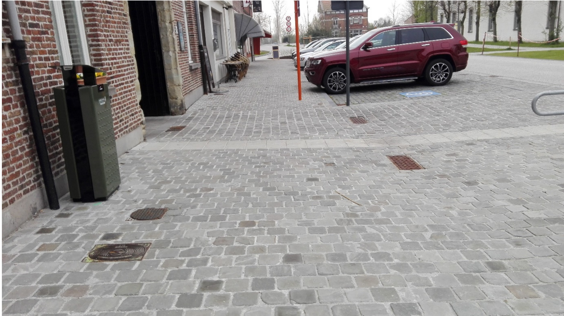
Voorbeeld pleinverharding in Grijze Kandla platines
